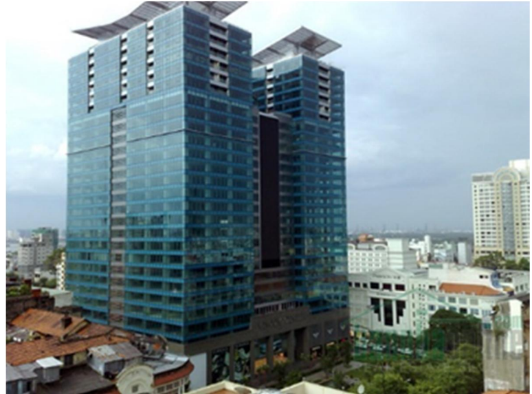
Hình 1: Vincom center TP HCM, một trong những Công trình “xanh” ở Việt Nam sử dụng kính Low-E, Photo © vanphongchothue.com.vn
