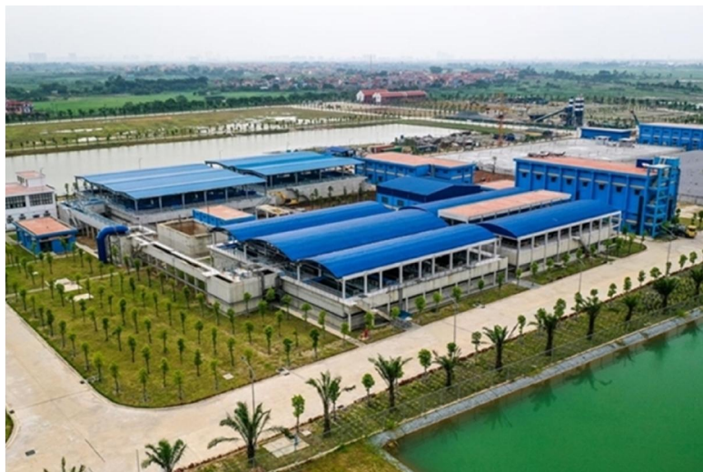
Hình: Nhà máy nước Sông Đuống, Photo © hoaphat.com.vn
