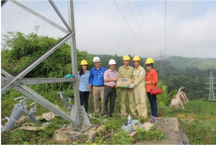
Hình 1: Đường dây 220KV Lào Cai-Hà, truyền dẫn điện nhập khẩu từ Trung Quốc sang Việt Nam, Photo © ptc1.com.vn
