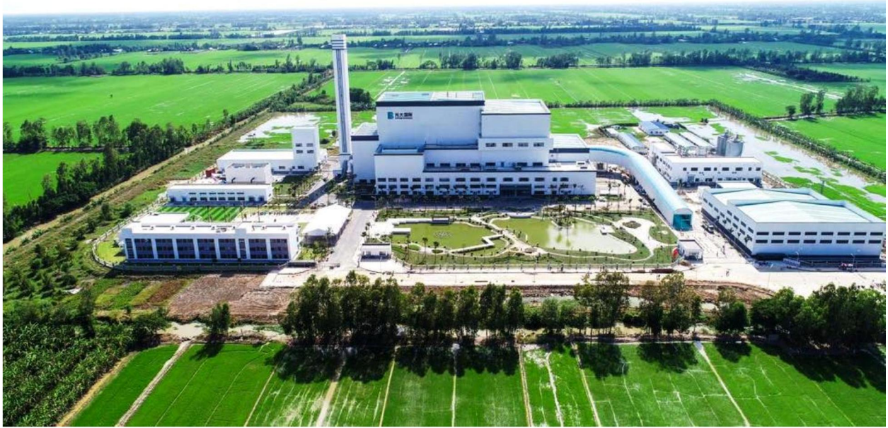
Hình 2: Nhà máy điện rác công nghệ thiêu đốt tại Cần Thơ đang vận hành
