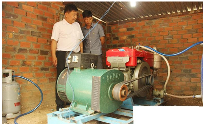
Hình 1: Máy phát điện sử dụng khí sinh học ở một hộ gia đình Bình Phước, Photo © baobinhphuoc.com.vn
