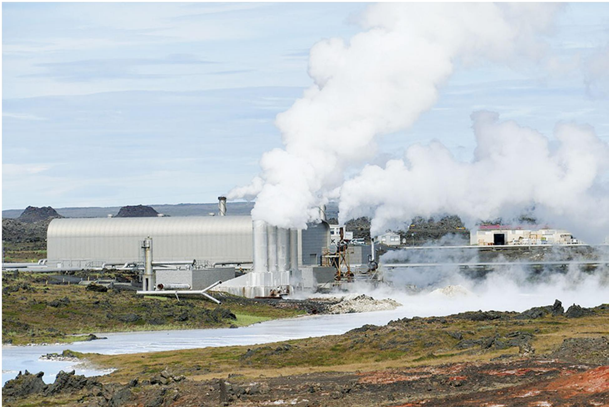
Hình 1: Minh họa một nhà máy nhiệt điện (nguồn: https://tietkiemnangluong.evn. )
